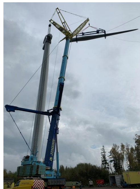
Förberedelse samt montage av begagnade blad på turbin 4
