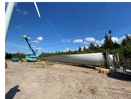
Förberedelse samt montage av begagnade blad på turbin 4
