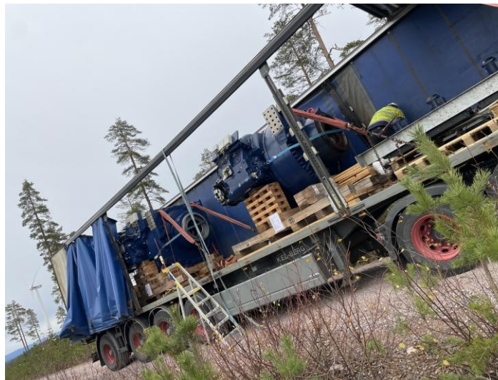
Dubbelbyte av växellådor på site Säliträdberget
