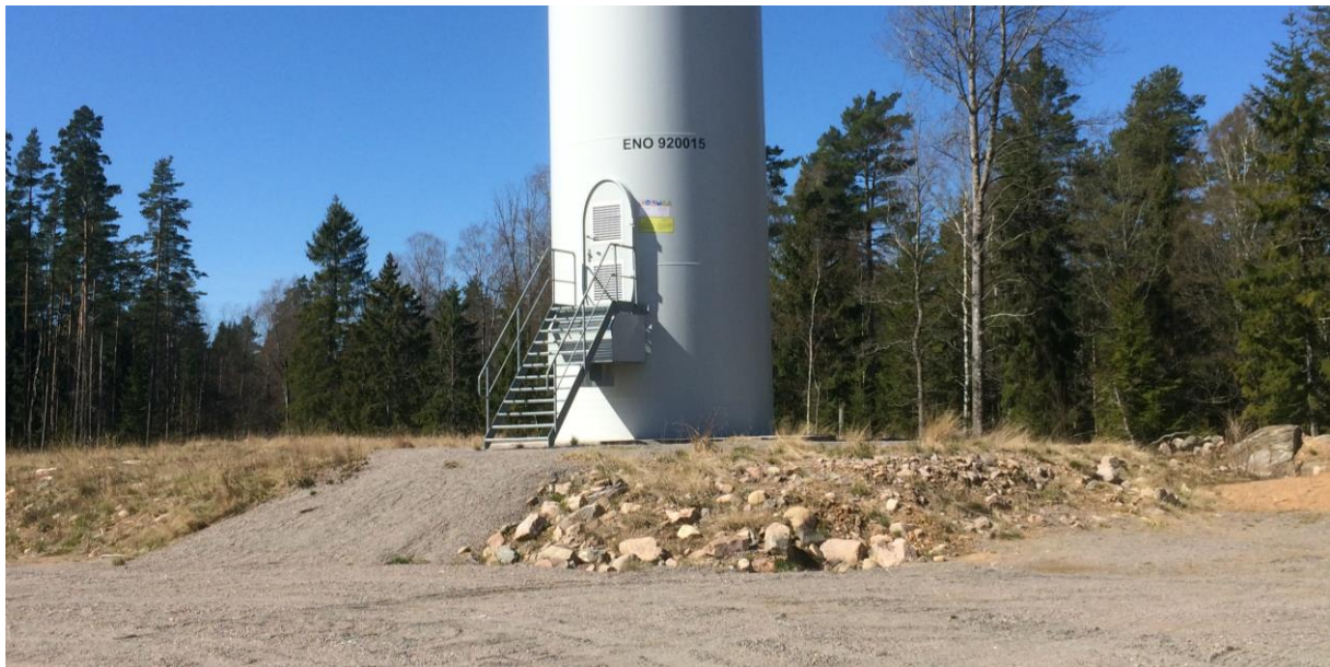
Figur 19. Exempel på hur ett gravitationsfundament kan se ut efter färdig byggnation.
