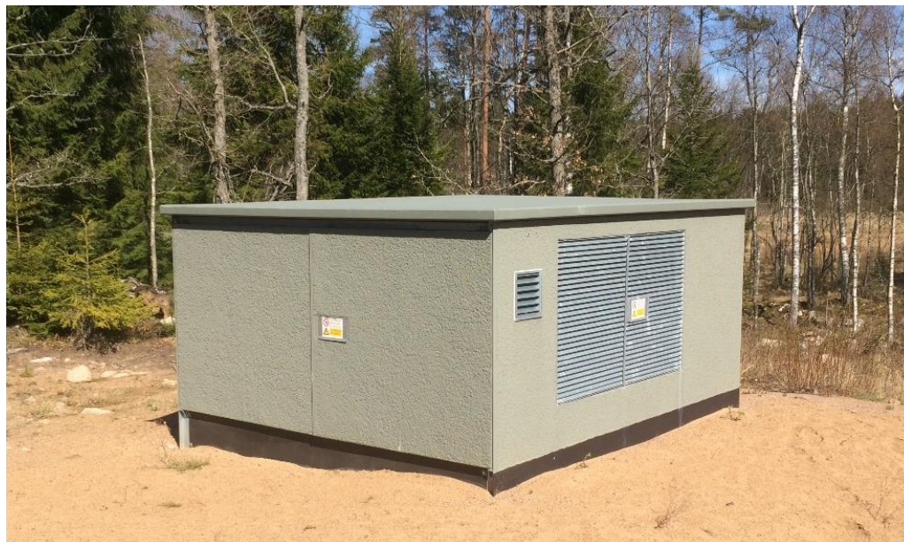
Figur 12. Exempel på hur en fristående transformatorstation kan se ut.
