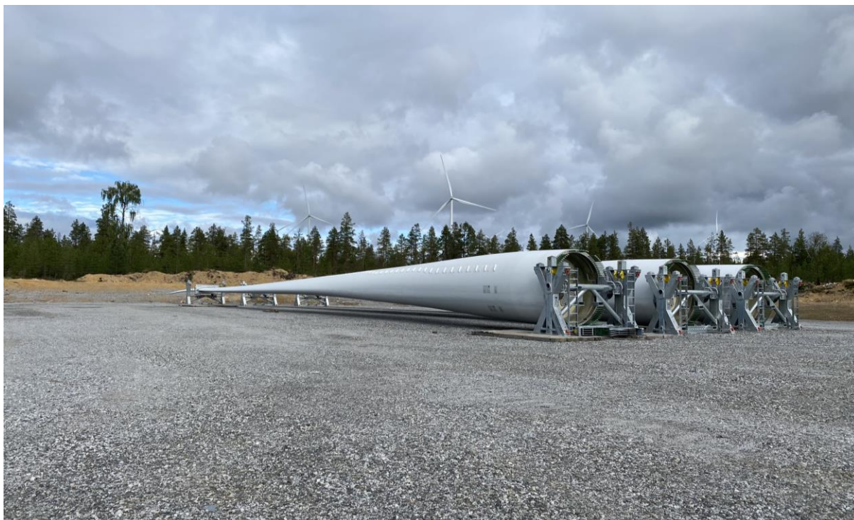
Figur 10. Exempel på hur en logistikyta kan se ut och användas. Foto från Markbygden ©Wind Sweden.
