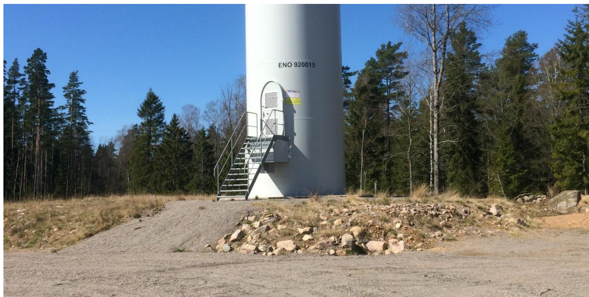
Figur 7. Exempel på hur ett gravitationsfundament kan se ut efter färdig byggnation.
