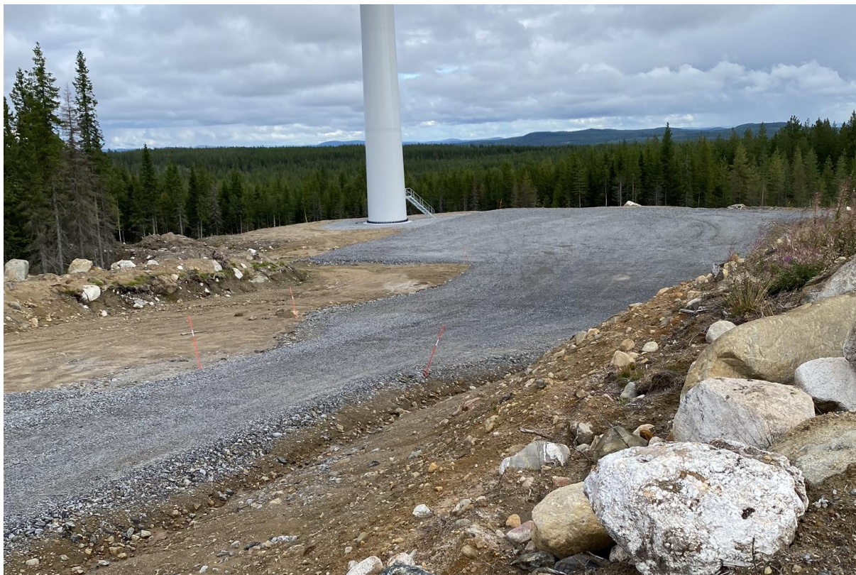
Figur 9. Exempel på hur en färdig kranplats kan se ut. Närmast i bild har marken grävts ur och längst bort i bild har marken byggts upp för att skapa en plan yta. Foto från Markbygden ©Wind Sweden.
